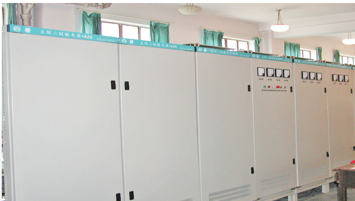
快速、无跟踪误差的高精度晶闸管 / IGBT 并联混合磁铁电源现场装置图
