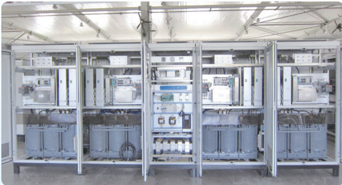
高精度 IGBT 串并联斩波磁铁电源现场装置图
